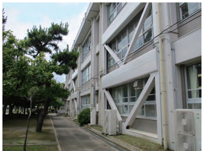
耐震工事を完了した校舎（写真は2023年現在のもの）
