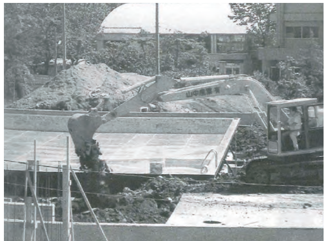
1980（昭和55）年 プール建設工事
