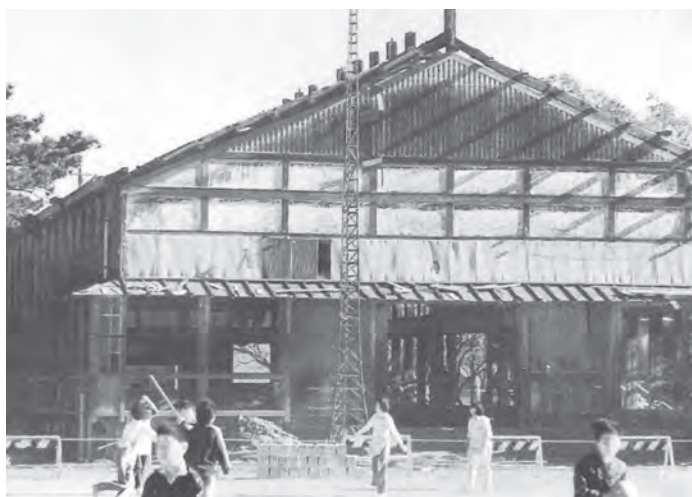
1976（昭和51）年 講堂解体工事
