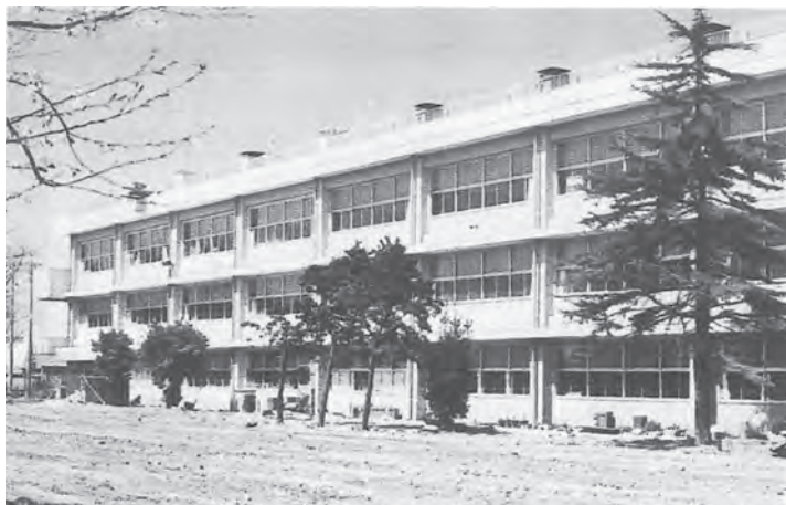
1972（昭和47）年 完成した現北校舎
